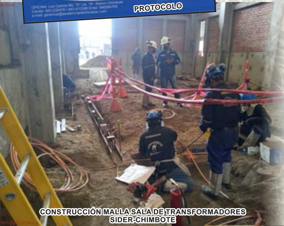
CONSTRUCCIÓN MALLA SALA DE TRANSFORMADORES SIDER-CHIMBOTE
