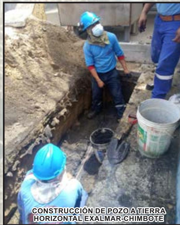
CONSTRUCCIÓN DE POZO A TIERRA HORIZONTAL EXALMAR-CHIMBOTE
